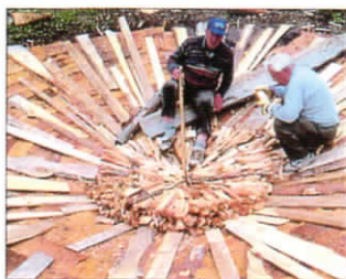
Bunden dækkes med bark og fyrretræ, som lægges med enderne mod midten.
